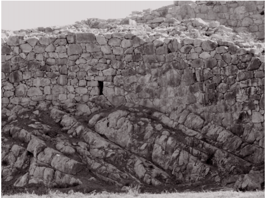
Zyklopische Mauer, grobe Bearbeitung, Tiryns (Foto des Autors)
